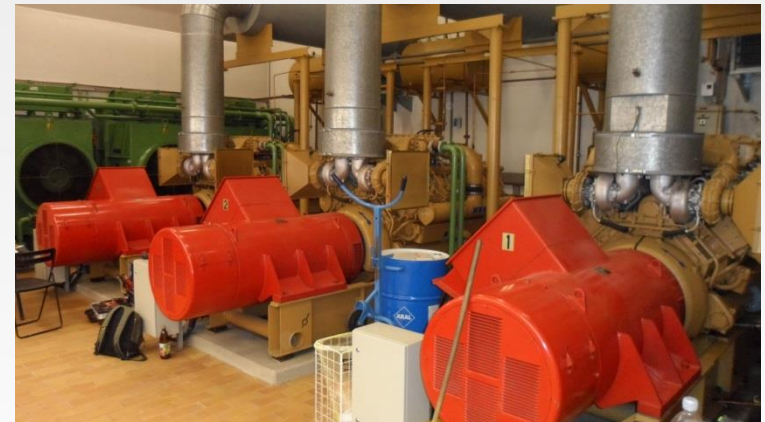
Projekt Pumpwerk in den Frenzen 3 x TBD 603V12 (2,4MW)
